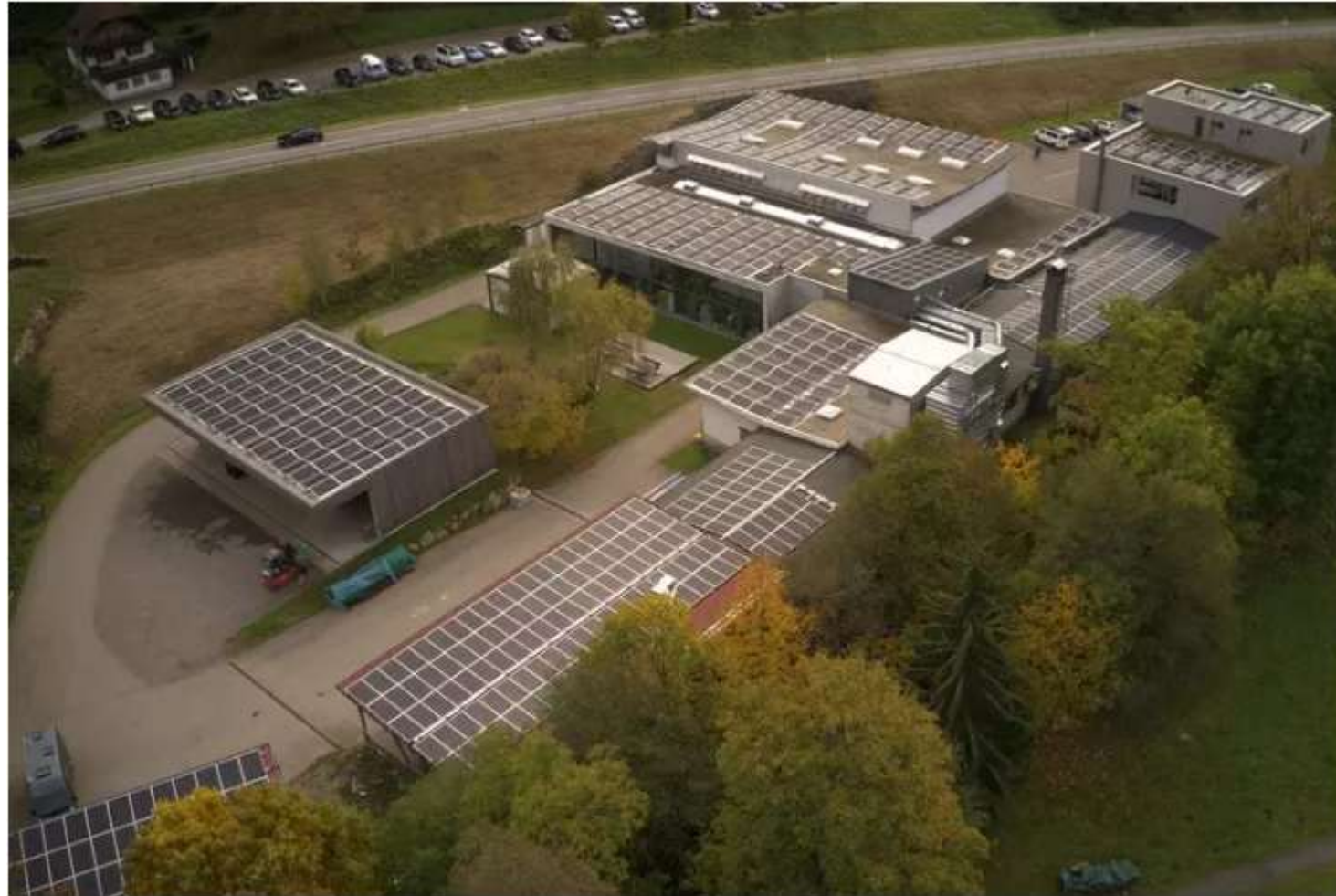
Firmengebäude aus der Vogelperspektive. Foto: Keller Energie GmbH
