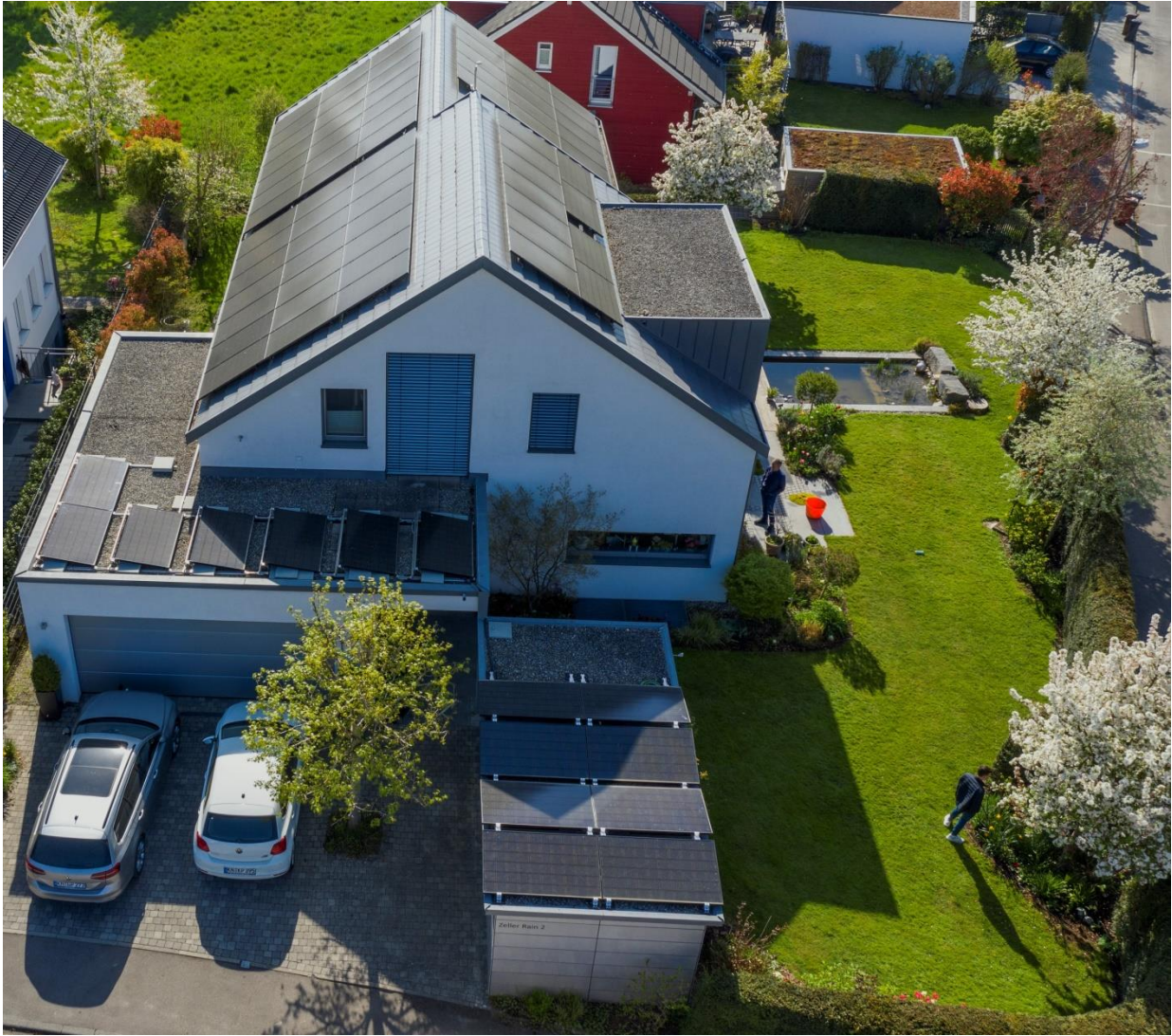
Photovoltaik auf Wohnhaus und Garage © Photovoltaik-Netzwerk BW/ Kuhnle&Knödler
